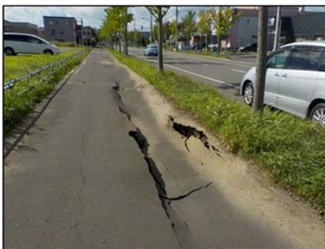
管路上部の地盤沈下
