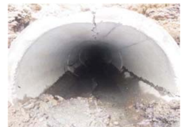
管路の老朽化の状況 (上部に亀裂の入った管路)
