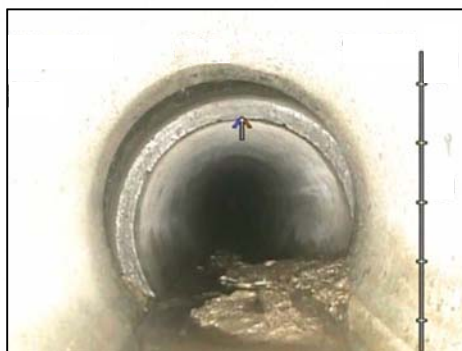
管路のつなぎ目のずれ
