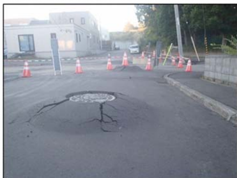
マンホールの浮き上がり
