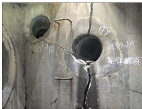
マンホールの破損
