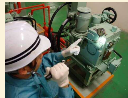
設備の点検・調査
