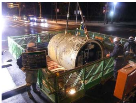
都心部の管路耐震化工事
