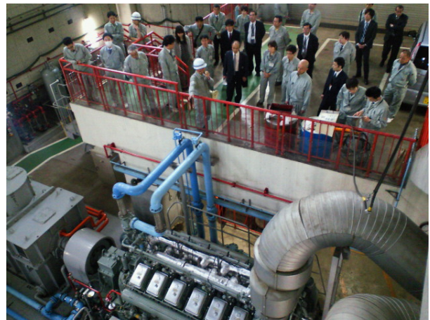
基礎研修での水再生プラザ見学
