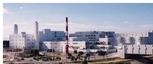
西部スラッジセンター概観
