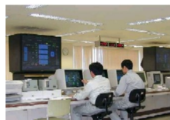
遠方監視状況
