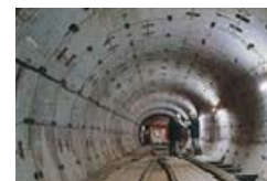
貯留管内部（既設）
