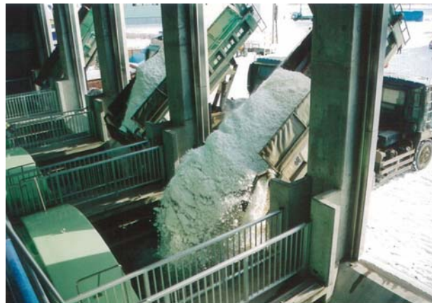
【下水道処理水を用いた雪処理施設(厚別融雪槽)】
