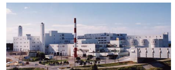
西部スラッジセンターの外観
