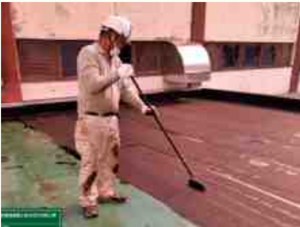
屋上の防水シートの修繕
