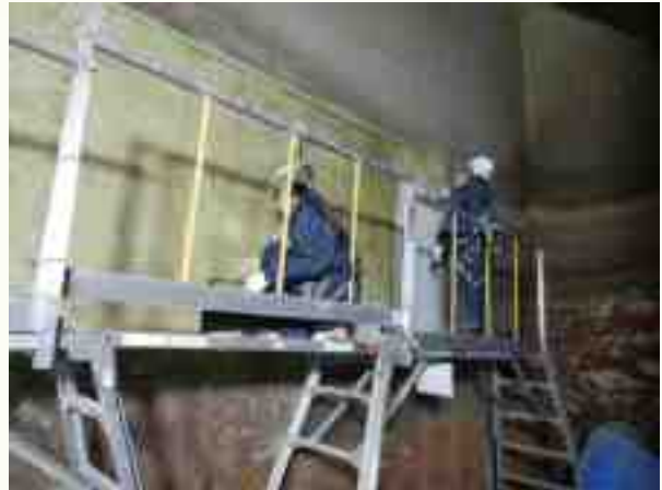
水槽の防食塗装の修繕
