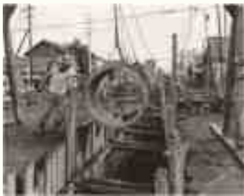
下水道の建設当初
