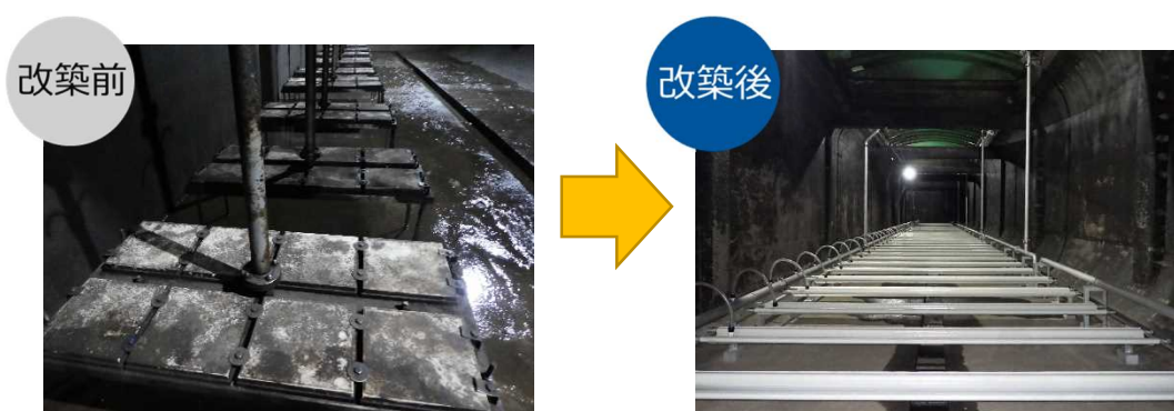
機械設備の改築（散気装置）
