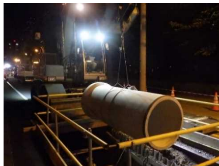
管路の耐震化（管路の入れ替え）
