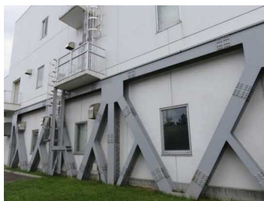
揚水施設の耐震化（外部補強）
