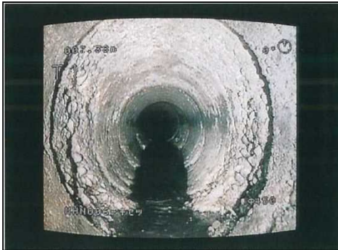
昭和初期に整備した下水管（老朽管）
