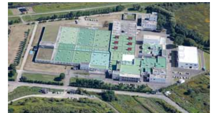
厚別 水再生プラザ
