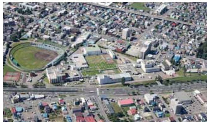
創成川 水再生プラザ
