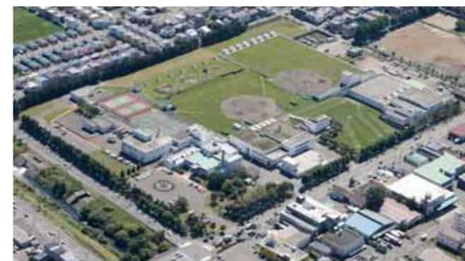
新川 水再生プラザ
