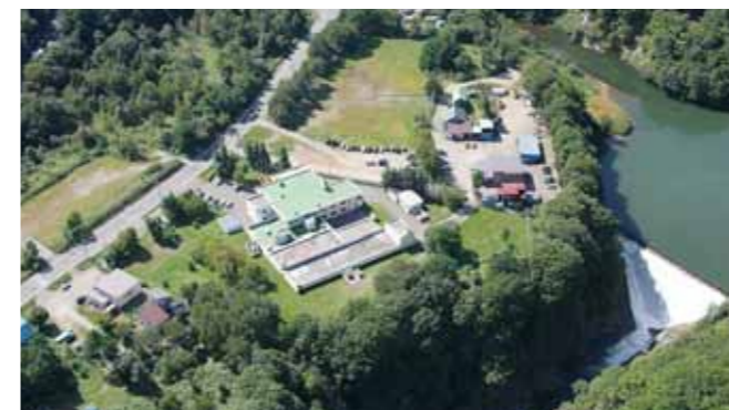
定山溪 水再生プラザ
