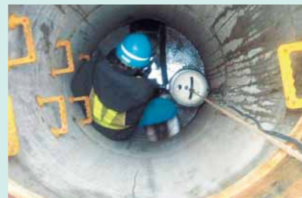
管内清掃作業の様子
