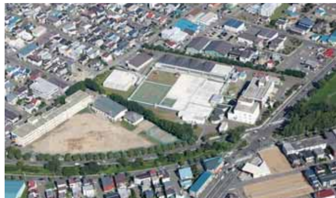
伏古川 水再生プラザ
