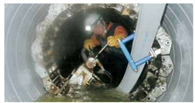
管路の耐震化工事の様子
