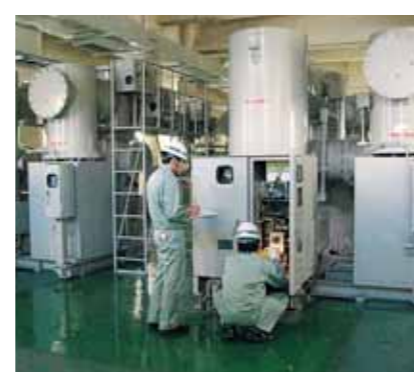
設備の点検・整備
