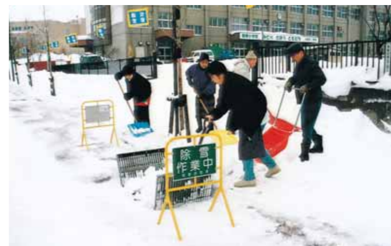
流雪溝投雪状況
