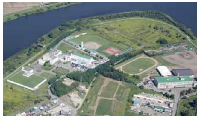
茨戸 水再生プラザ
