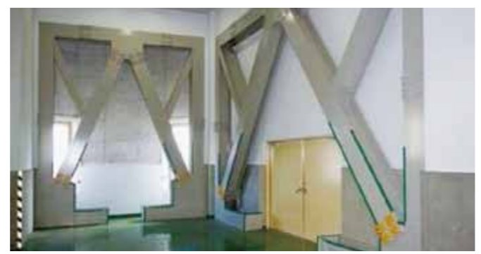
水再生プラザの耐震補強状況
