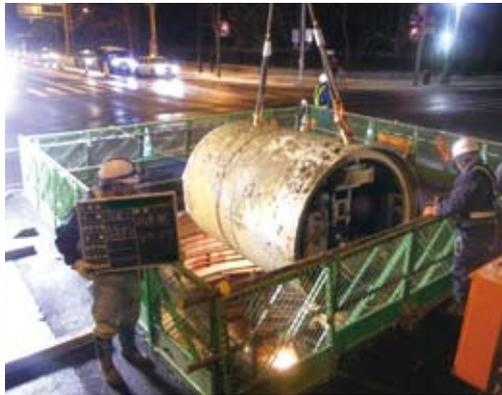
緊急輸送道路下の下水道管を、耐震性が十分なものに取り替えます。
