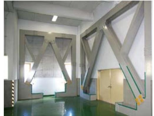
水再生プラザ管理棟の壁に耐震補強を行っています。
