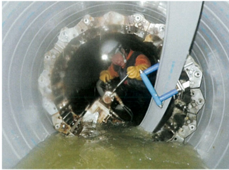
管路の耐震化工事
