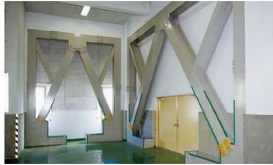
水再生プラザの耐震補強
