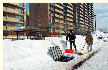
処理水を利用した流雪溝
