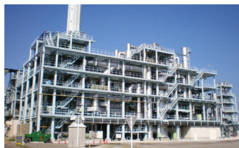
汚泥を燃料化する施設(東京都)
