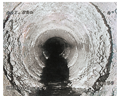
老朽管路のテレビカメラ調査
