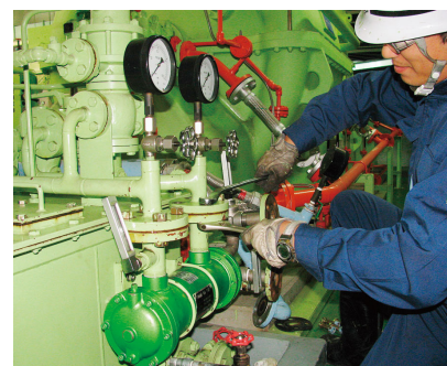
処理施設の保守点検
