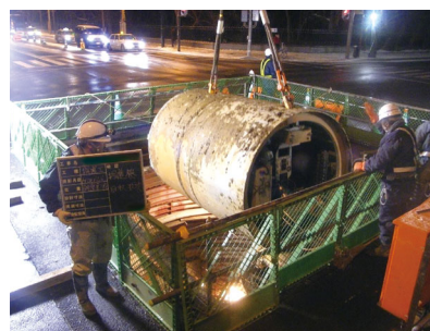
都心部の管路耐震化工事
