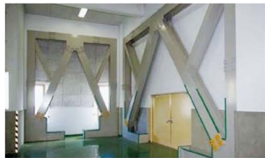
○水再生プラザの耐震補強状況
