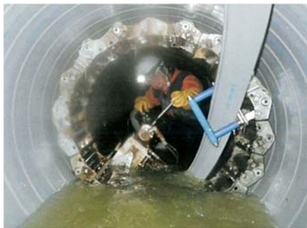
○管路の耐震化工事の様子
