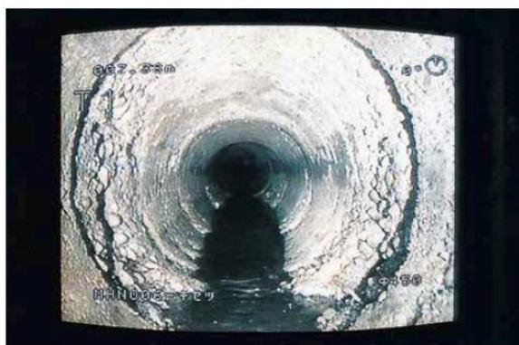
昭和初期に整備した下水道管（老朽管）
