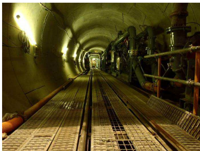
【豊平川雨水貯留管建設中の様子】
