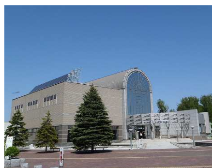
下水道科学館への太陽光発電の導入
