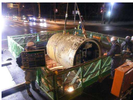
都心部の管路耐震化工事
