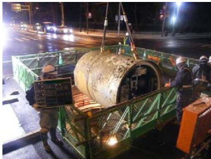
都心部の管路耐震化工事
