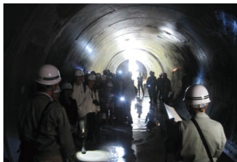
豊平川雨水貯留管見学会
