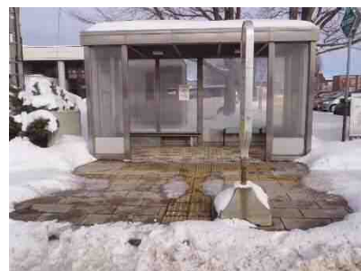
図 3-11 ロードヒーティング
