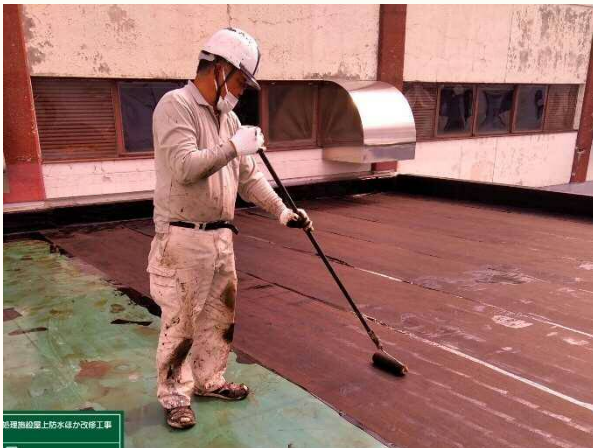
屋上の防水シートの修繕
