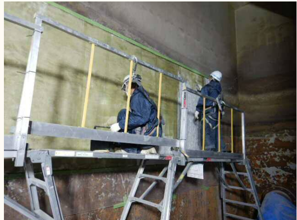
水槽の防食塗装の修繕
