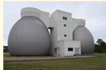
消化槽 (岩見沢市 南光園処理場)
