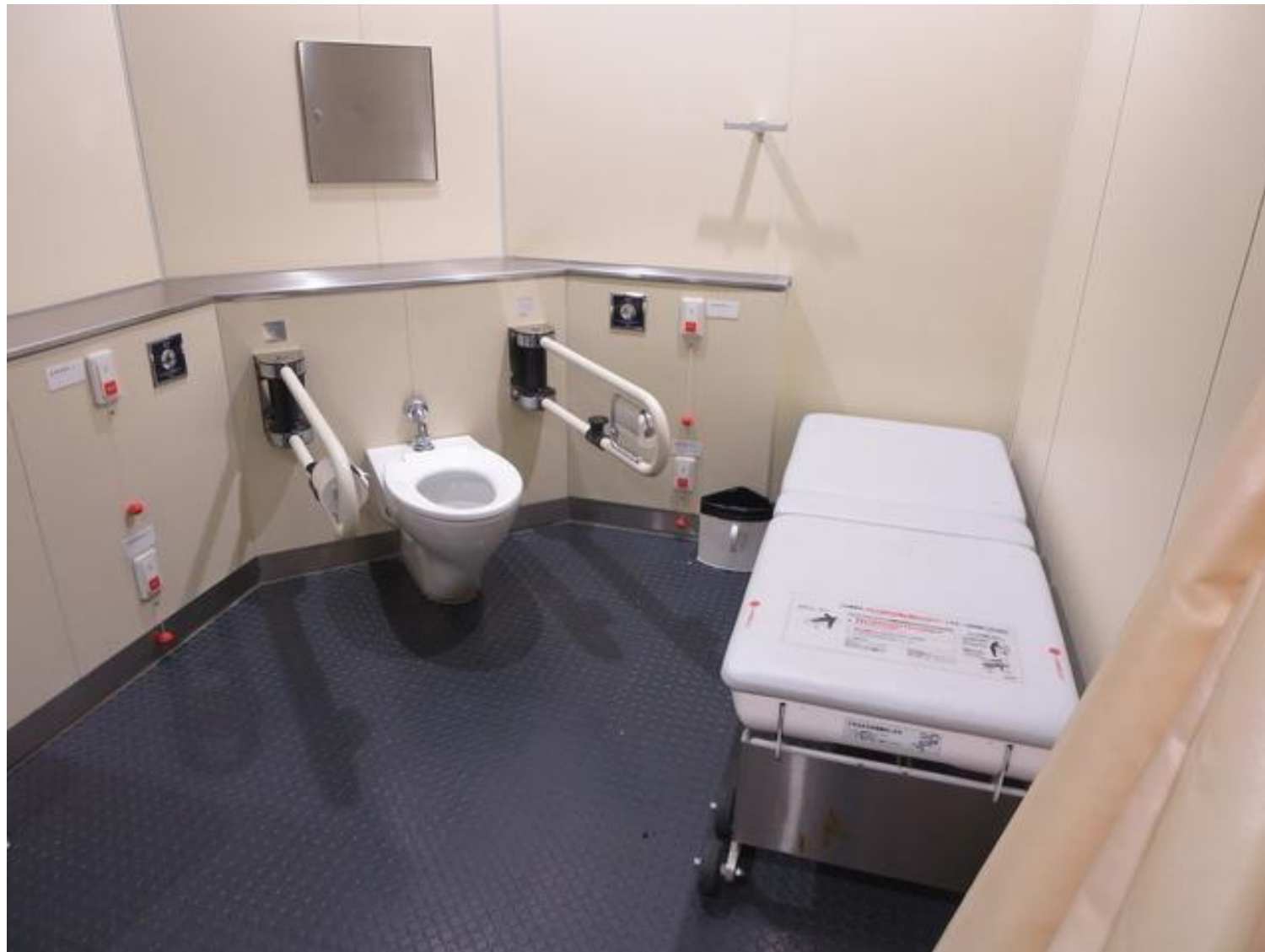
図 地下鉄大通駅のバリアフリートイレの整備事例
