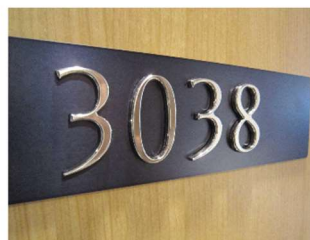
・数字と背景の色の組み合わせを工夫した、浮き文字による室番号表示
