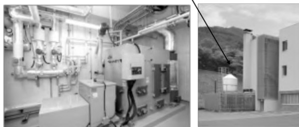
図5 ペレットボイラーシステム
