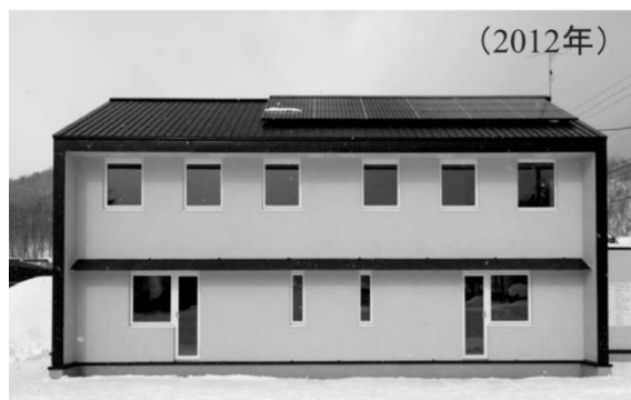
写真2.2 喜茂別町のnear Net Zero Energy公営住宅
