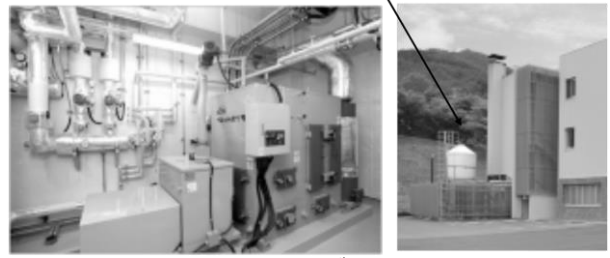
図5 ペレットボイラーシステム
