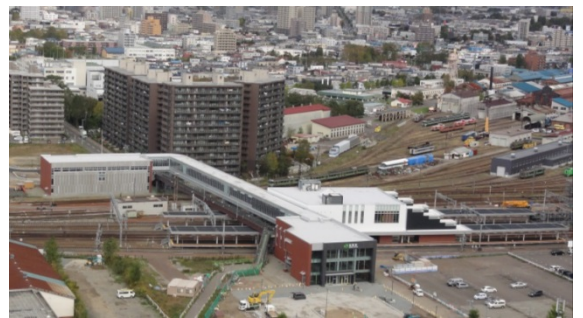
▲南口状況写真(2018.10撮影)
