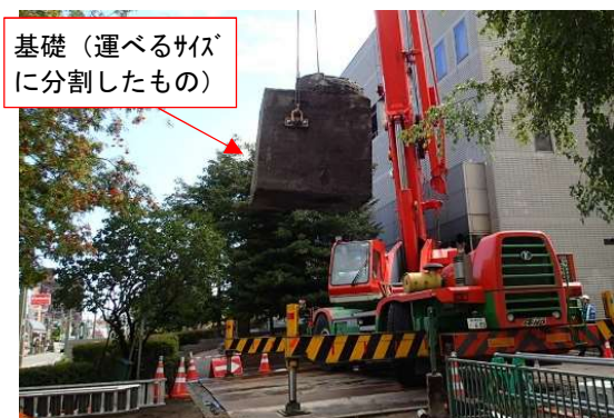
（参考写真）基礎部 撤去状況
