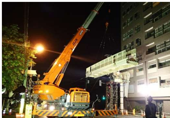
（参考写真）地上部 撤去状況
