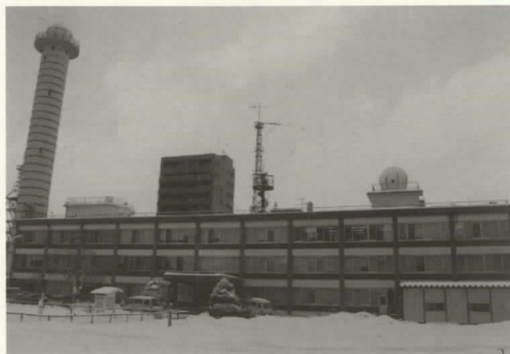
現在の札幌管区気象台
