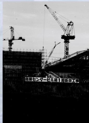
厚別副都心商業センター建設工事
