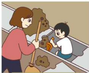
排水溝の掃除をしましょう 排水溝や雨水ますが落ち葉や土で詰まっていると、雨水が流れずあふれることがあります。
