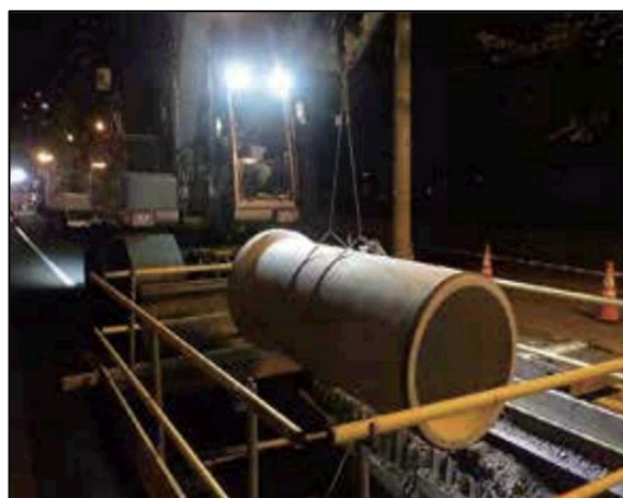
写真：緊急輸送道路に埋設された管路の耐震化
