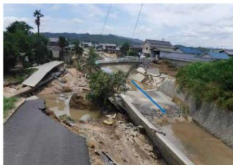
平成30年7月豪雨による被災状況(高梁川水系小田川)
