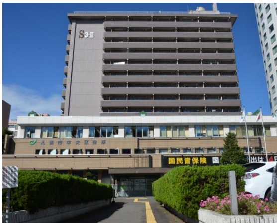
写真：改築計画中の中央区役所
