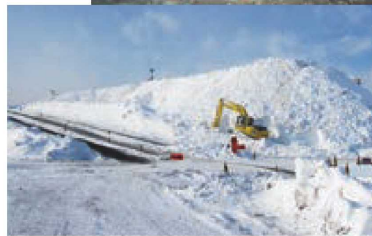
写真上:夜間の除雪の様子 写真下:雪たい積場
