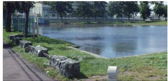
白石区 白生公園湛水状況(H26.9)
