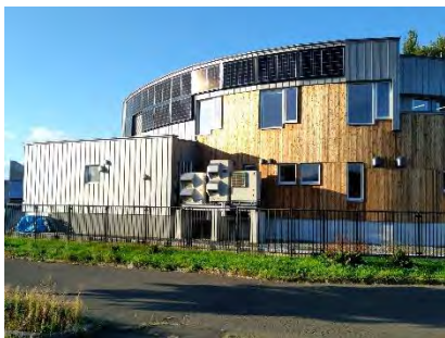
南面外壁に垂直設置した太陽電池モジュール
