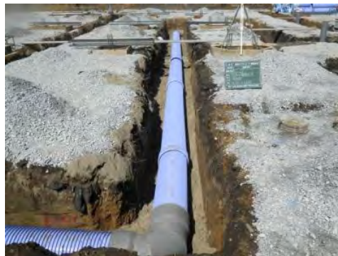
アースチューブ（地中熱交換器） 積水化学北海道社製
