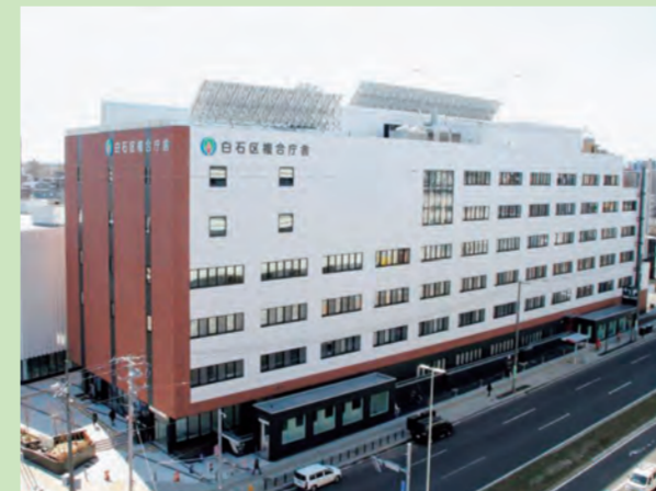
白石区複合庁舎共用開始 (平成28.11)
