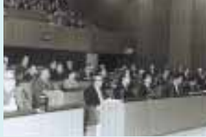
昭和46年12月3日新議場での初議会 市庁舎建設構想時、議場は別棟にするべきなども話し合われましたが、最終的に市庁舎の17階、18階部分につくられました。
